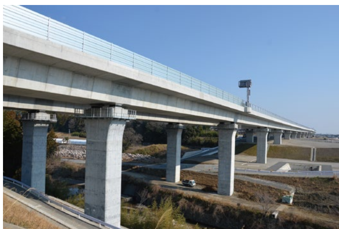
新名神高速道路 鈴鹿高架橋
