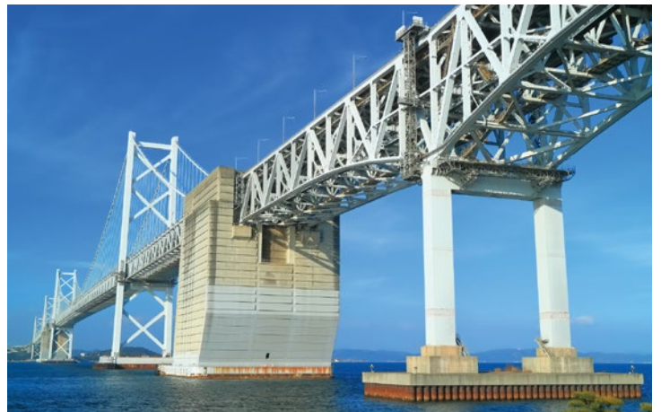
備讃瀬戸大橋
