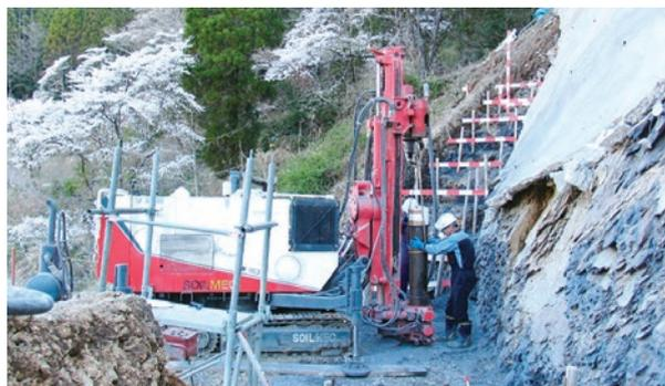
● **さく井・各種調査井工事** 大深度穿孔でケーシングパイプを回収しない場合は、ノーマルモデルのリングビットを推奨します。尚、一時的なケーシングなどで、後から撤去する場合は、マルチユースモデルを推奨します。
