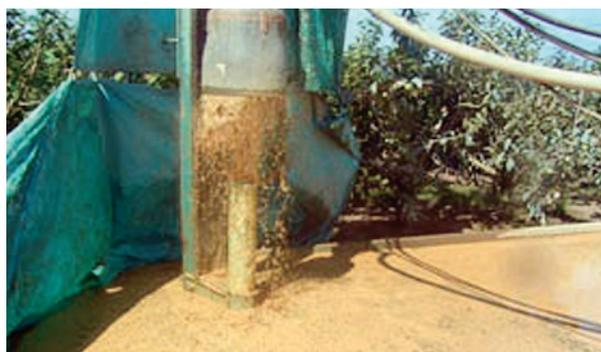
● **パイプルーフ・アンカー工事** 斜めや水平穿孔でも作業方向に影響なく、確実なケーシング穿孔が可能です。
