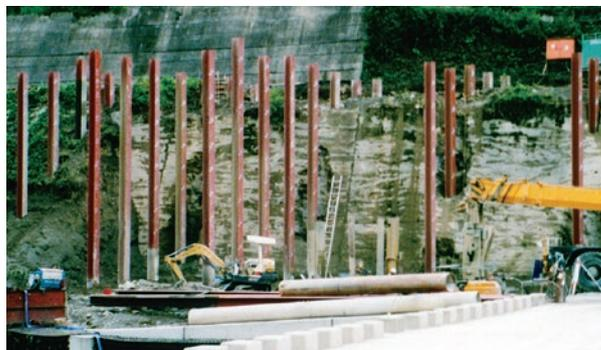
● **マイクロパイル工事** 根入れ層の岩盤でも穿孔効率の良さが評価されています。
