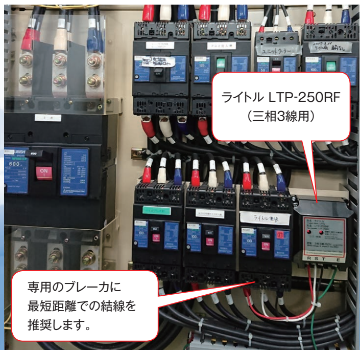
工場配電盤への設置例
