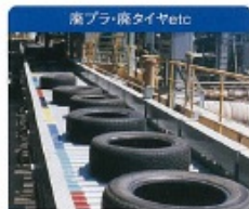
廃プラ・廃タイヤetc 廃タイヤ投入設備 廃プラ、木くず、廃タイヤなどを燃料・原料代替として大量に有効活用しています。タイヤ中のスチールワイヤーも鉄原料代替としてセメント成分になります。
